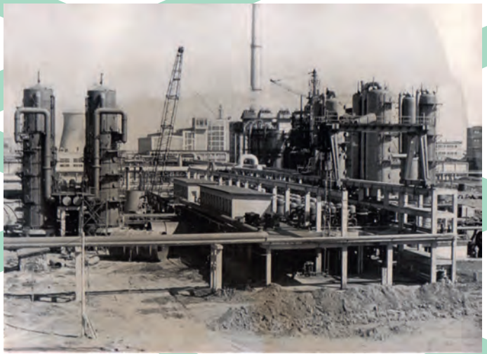
TEERVERARBEITUNGSANLAGE IM WERK ESPENHAIN
