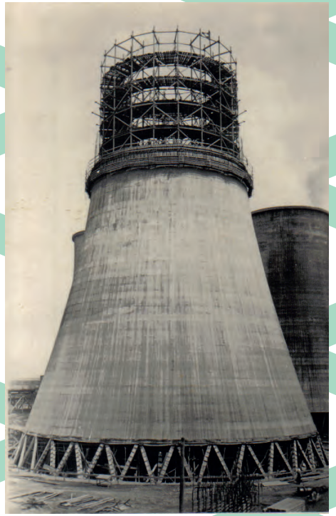
AUSBAU DER KÜHLTÜRME IM WERK ESPENHAIN
